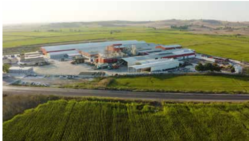
Tukaş Balıkesir-Manyas Fabrikası/ Balıkesir-Manyas Facility
